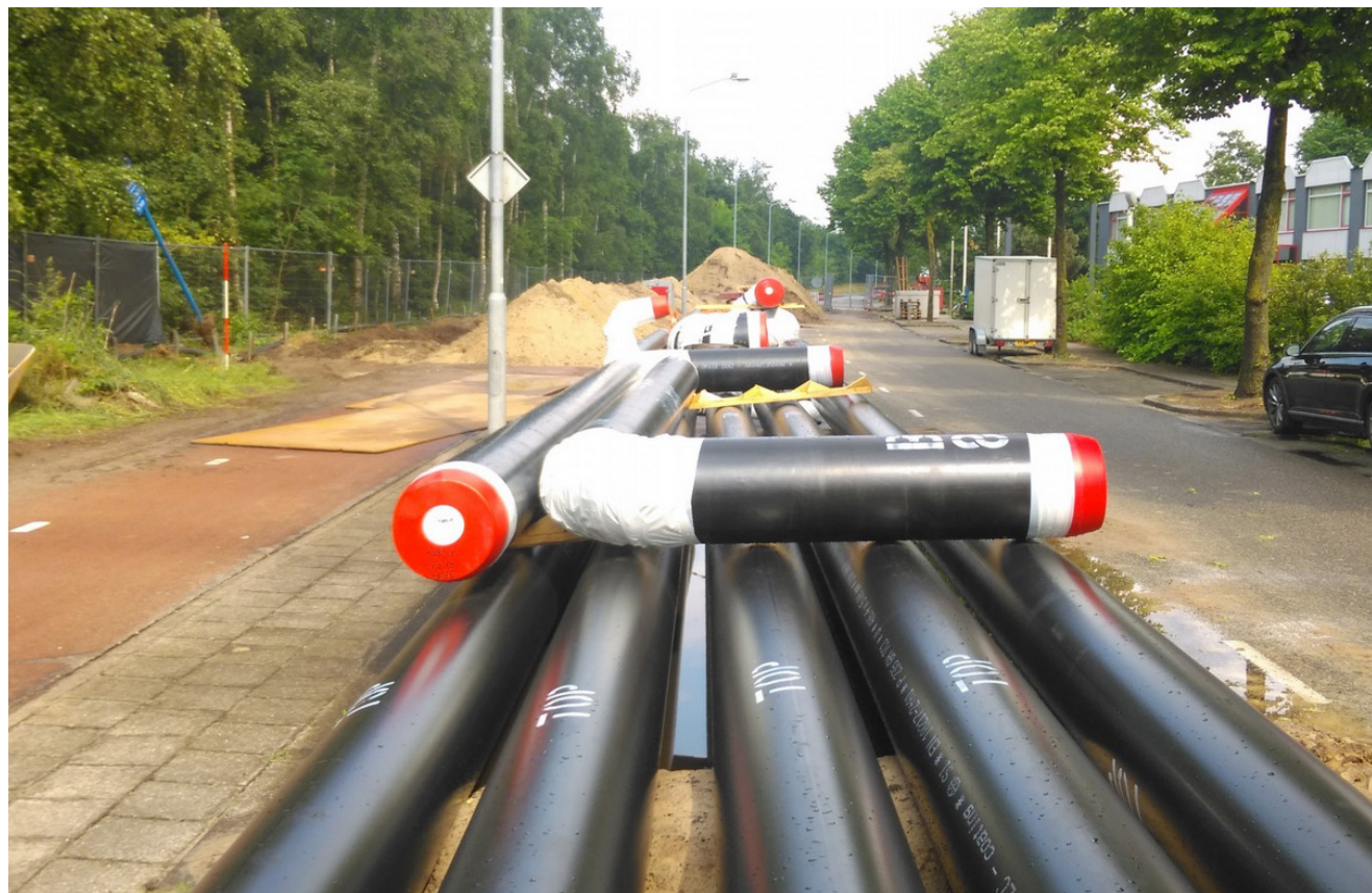
Aanleg van warmtenet (foto: Warmtebedrijf Ede)
