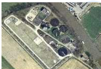
Luchtfoto van de RWZI
